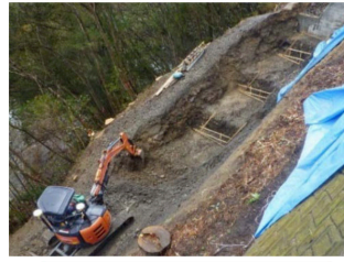
ICT建機による掘削作業
